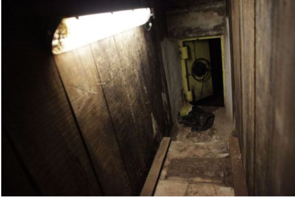
A csatorna a ház alatt:
